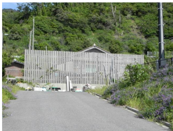
島後・油井集落の防風・防潮壁
